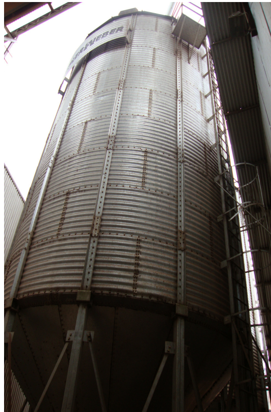
Figura 12: Silo de armazenagem
