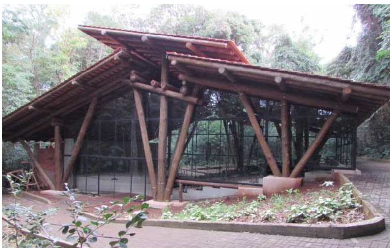
Figura 9 - Vista exterior do Anfiteatro Fonte: Autoria própria
