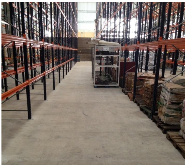
Figura 19 - Piso antes da reforma Fonte: O autor (2014)
