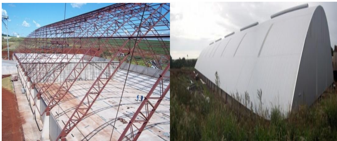
Figura 17 – Armazém Graneleiro – 6.300,00 m 2 Fonte: Acervo da Fábrica, 2012.
