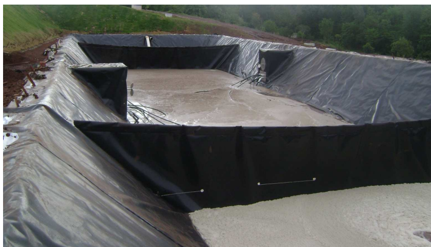
Figura 11 – Carga do reator e chicanas internas
