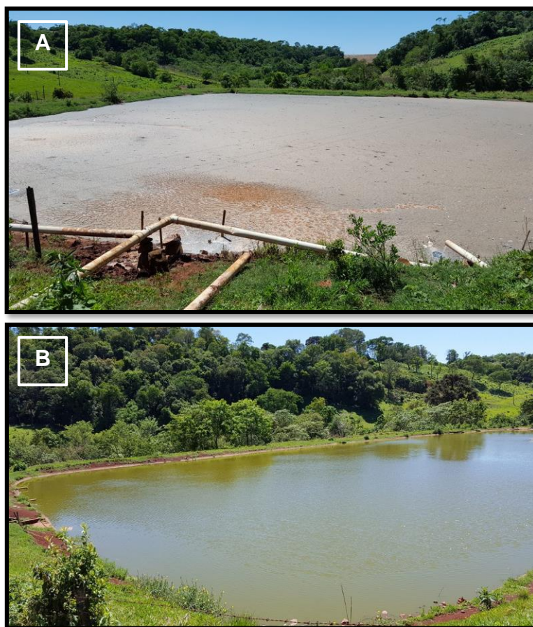
Figura 7 – Tratamento Secundário: A – Lagoa Anaeróbia; B – Lagoa Facultativa Fonte: Autoria própria, 2016
