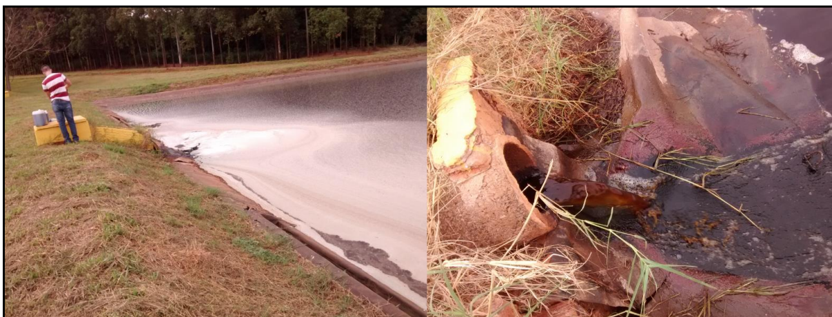
Figura 05: Lagoa de conteeção (à esquerda) com detalhe do ponto de coleta (à direita)
