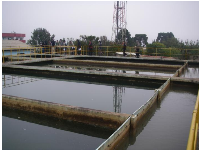
Figura 6 – Visita à SANEPAR – Tanques de tratamento da água Fonte: Arquivo da autora (2011)
