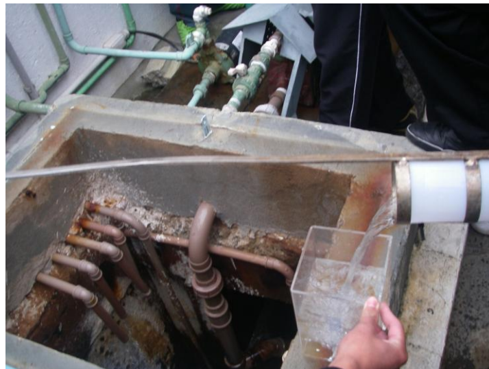
Figura 8 – Visita à SANEPAR – Cloração: etapa final do tratamento da água Fonte: Arquivo da autora (2011)
