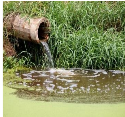
Figura 11- Lançamento do Esgoto nos Rios Fonte: BRASILESCOLA 11
