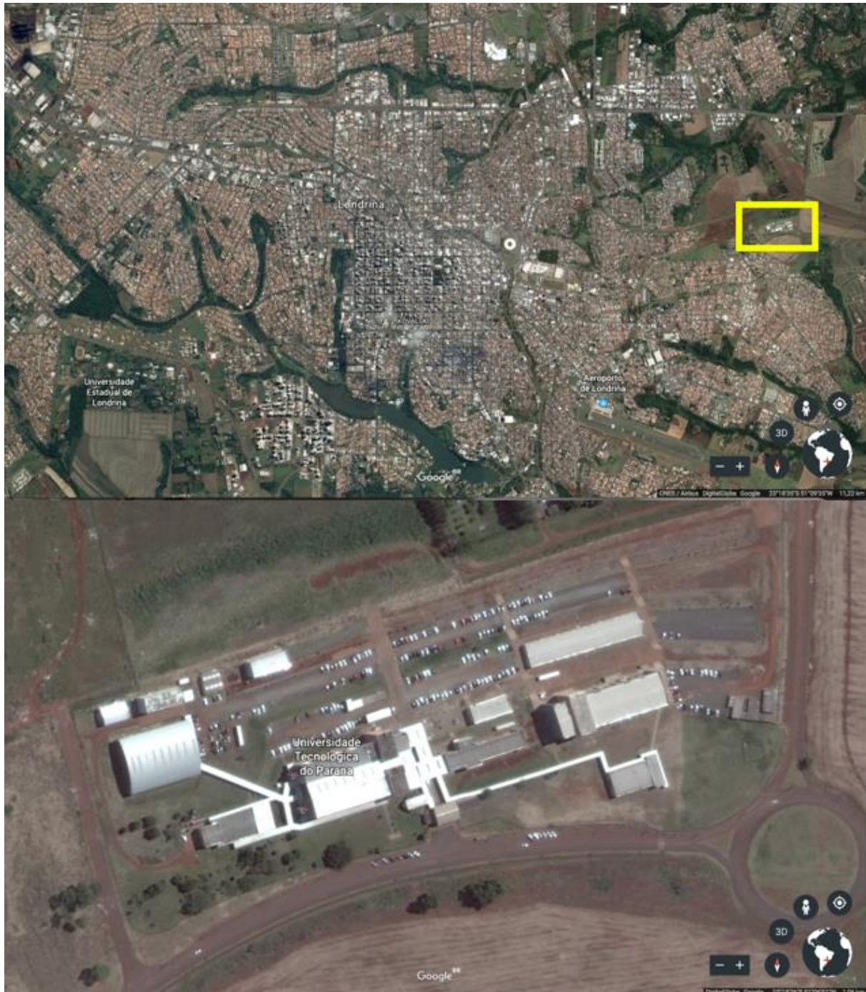
Figura 12 – Imagens aéreas da localização e do próprio Câmpus Londrina.
