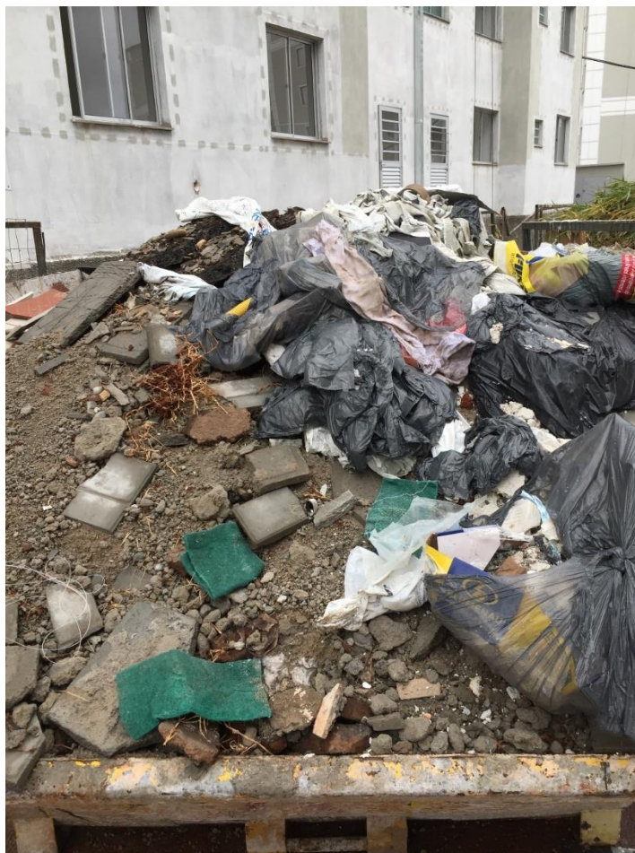
Figura 2: Mistura de resíduos observada na caçamba do CTR nº32
