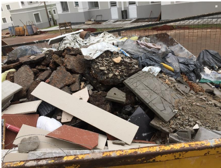
Figura 3: Mistura de resíduos observada na caçamba do CTR nº42
