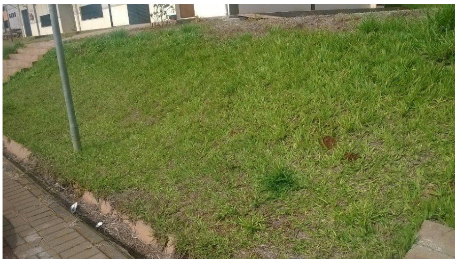
Figura 17: Presença de grama nos taludes para reduzir efeitos erosivos. Fonte: Autoria própria, 2015.
