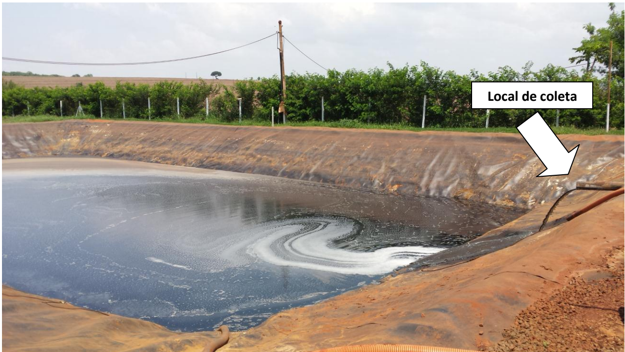
Figura 4: Localização das Lagoas de estabilização da CTR de Londrina-PR
