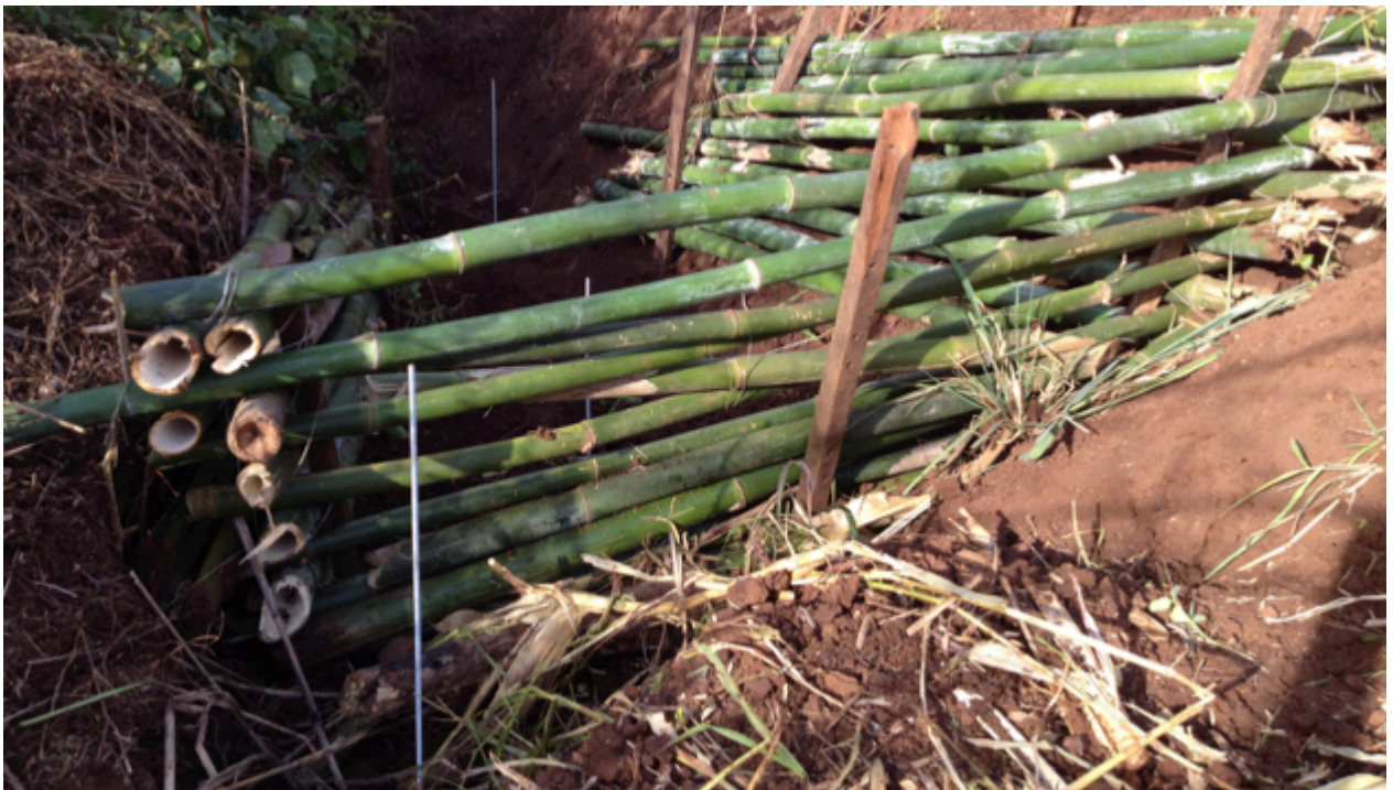
Figura 11 – Barreiras construídas e varas de monitoramento reinstaladas. Fonte: Autoria Própria.
