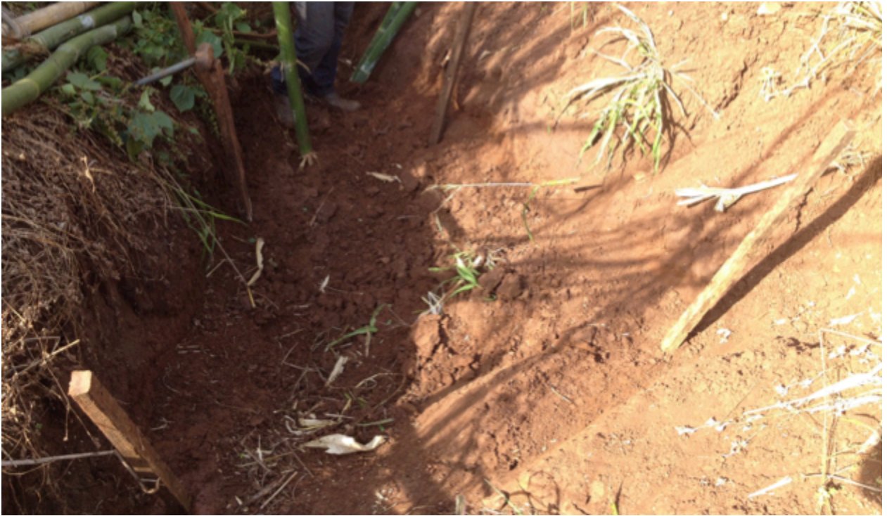
Figura 10 – Início da construção das barreiras de contenção. Fonte: Autoria Própria
