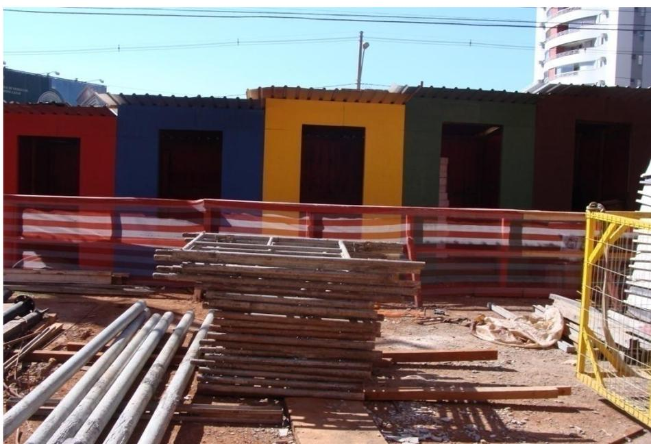
**Figura 27:** Baias pintadas com identificações que não correspondiam com o material acondicionado.
