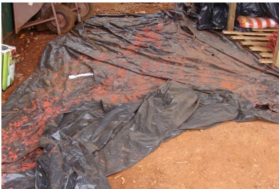
**Figura 41: Lona utilizada no local de pintura para proteger o solo.
