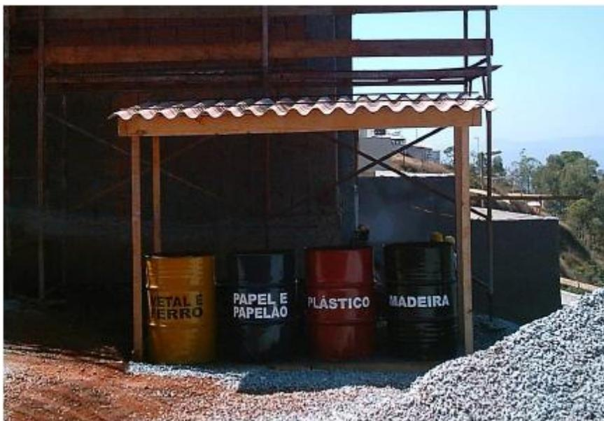
Figura 8: Tambores de 200 L para o descarte de metal e ferro, papel e papelão, plástico e madeira.
