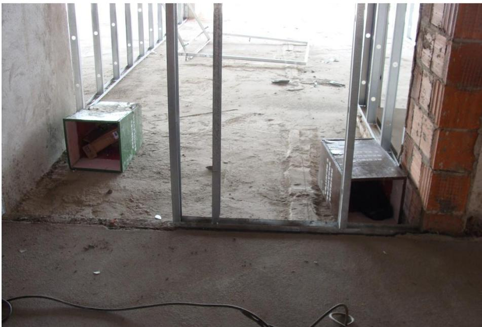
**Figura 34: Coletores fora do local combinado.**
