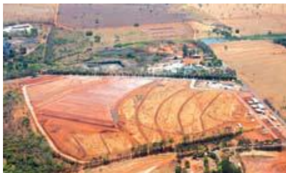
Figura 2: Exemplo de Aterro sanitário no estado de Minas Gerais.
