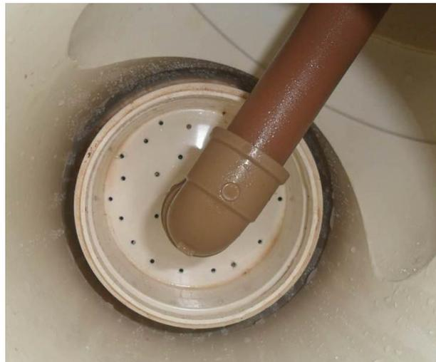
Figura 10 – Distribuidor de água residuária no topo da torre de *stripping*
