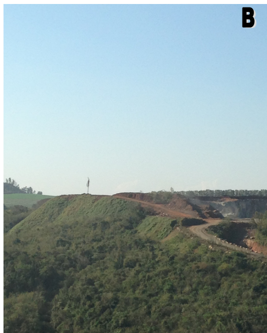
Figura 7.5. Aterro de decapeamento: A) Antes do plantio vegetal e B) Depois do plantio vegetal.
