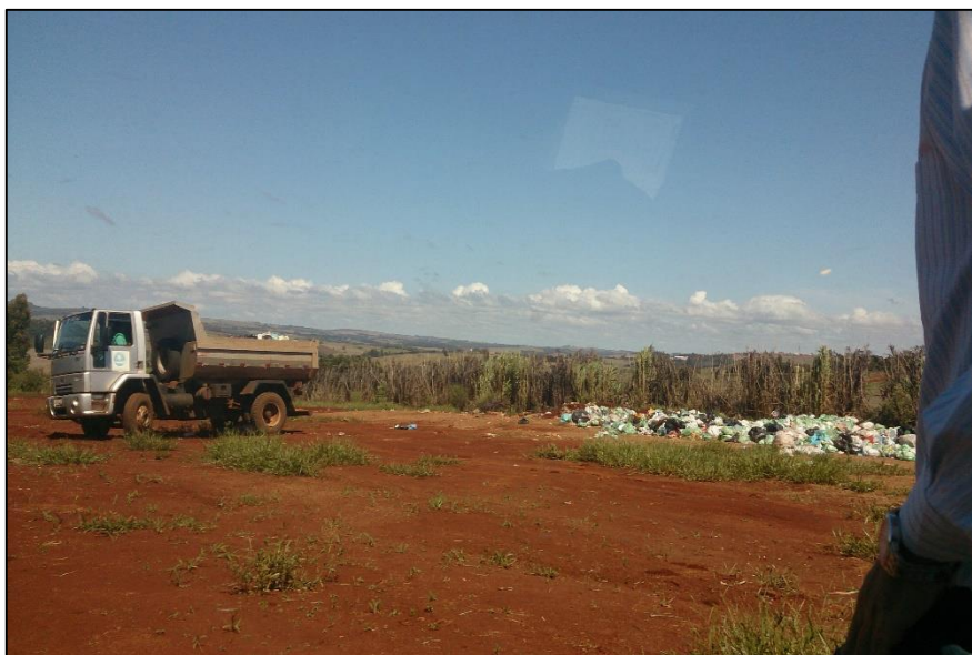
Figura 10- Ausência de recobrimento diário dos resíduos sólidos. Fonte: Autoria própria.
