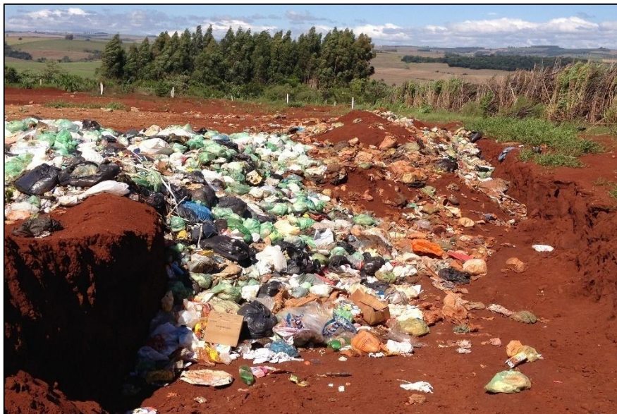
Figura 9- Vala para disposição final de resíduos sólidos - Nova Santa Bárbara/PR. Fonte: Autoria própria.
