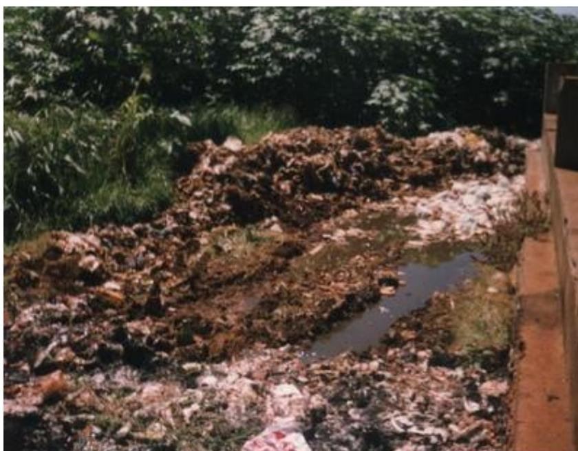
**Figura 25 – Ausência de drenos condutores de chorume, águas superficiais e gases.**
