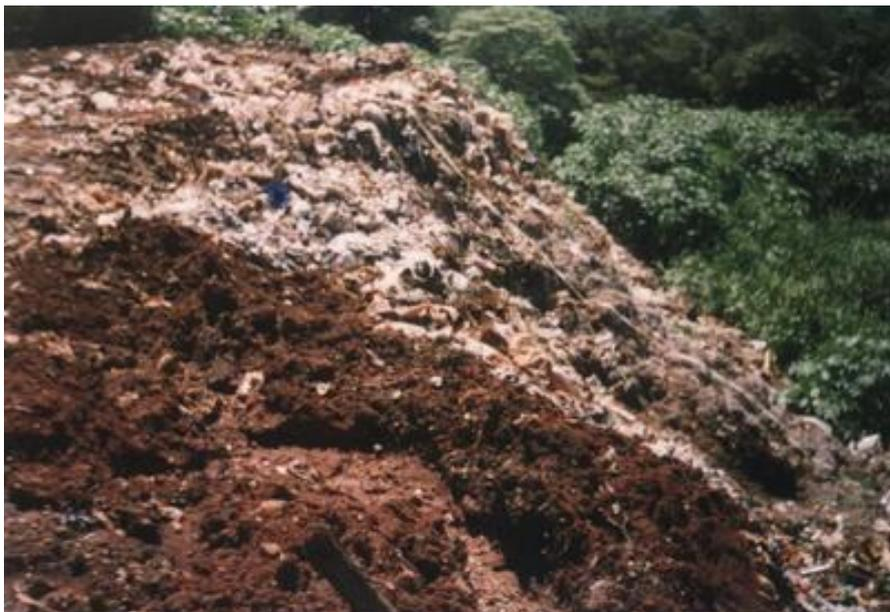
**Figura 24 - Talude formado pelo despejo incorreto dos caminhões de coleta municipal e esteira de compactação.
