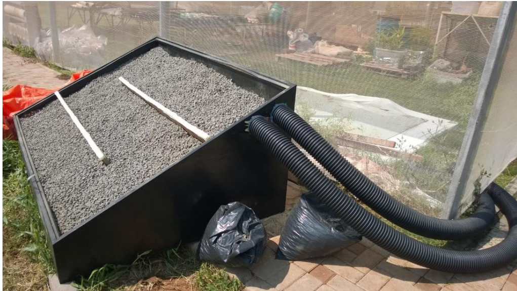
Figura 14. Colocação de brita no interior da caixa de aquecimento.
