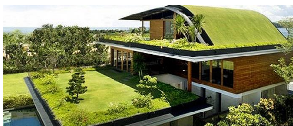
Figura 1 - Telhado Verde Fonte: ECOTELHADO (2013).
