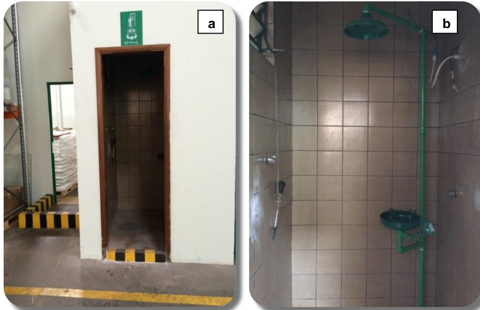
(a) Faixas de Sinalização
