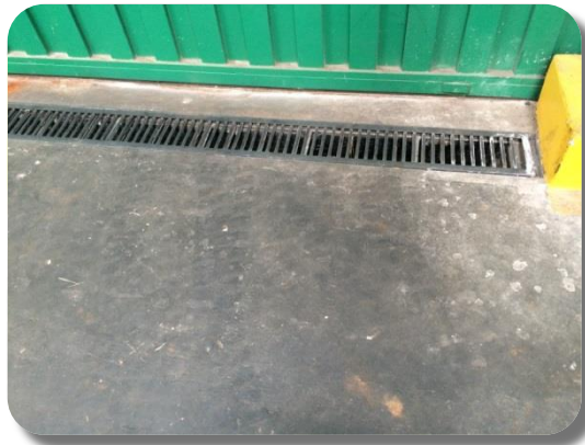
Figura 9 - Piso com grelha Fonte: Próprio autor.
