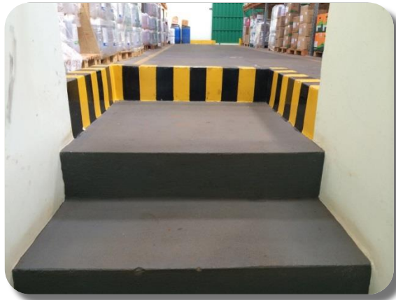
Figura 3 - Acesso para entrada dos funcionários com mureta sinalizada. Fonte: Próprio Autor.
