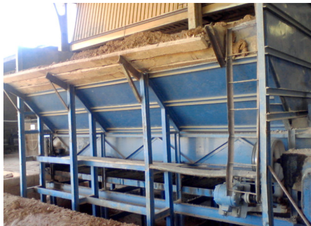
Figura 24 - Caixão alimentador Fonte: Autor (2014).
