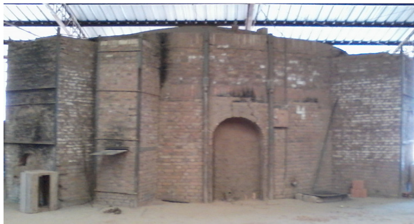
Figura 34 – Estrutura do forno abóboda Fonte: Autor (2014).
