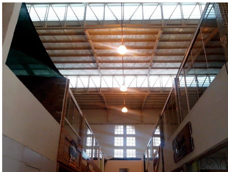
Figura 29 – Corredor com telhas translúcidas e luzes acesas. Fonte: Autoria própria.
