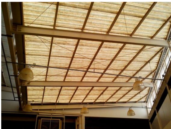
Figura 26 – Telhas translúcidas da praça de alimentação com as luzes apagadas. Fonte: A autoria própria.
