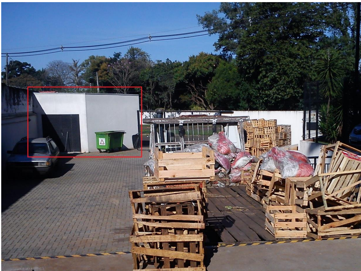
Figura 36 – Localização do abrigo de resíduos. Fonte: Autoria própria.
