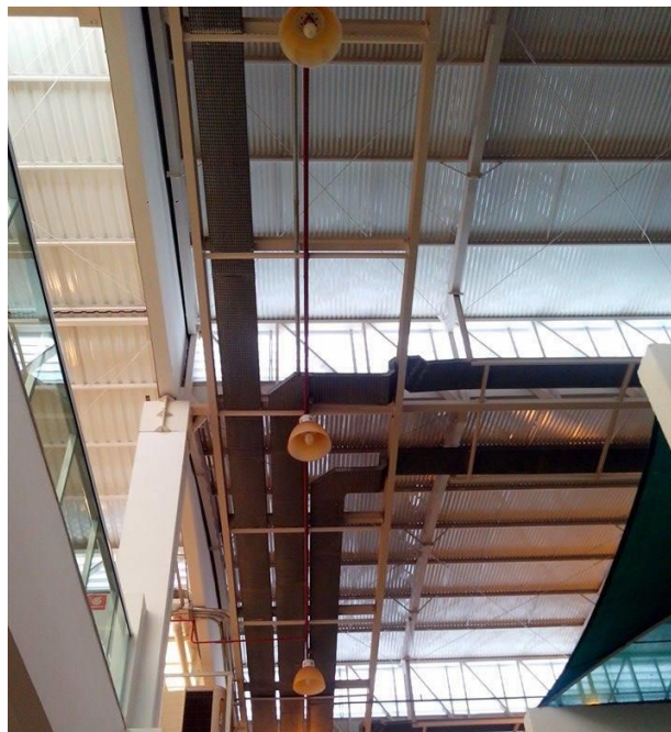
Figura 28 – Corredor com telhas translúcidas e luzes apagadas. Fonte: Autoria própria.
