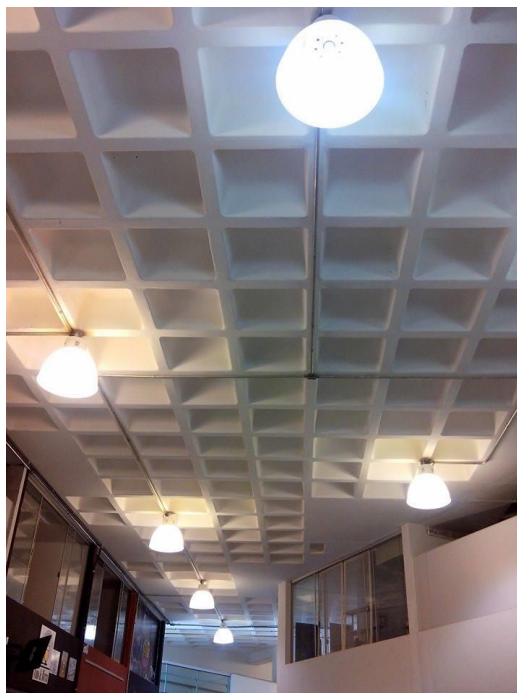
Figura 30 – Área abaixo do mezanino com as luzes acesas. Fonte: Autoria própria.
