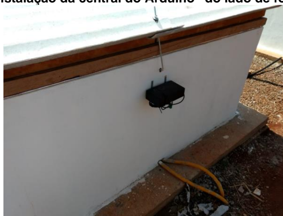
Figura 18 – Instalação da central do Arduino® do lado de fora do modelo.
