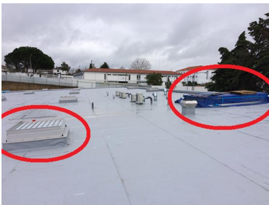
Figura 20 - Localização das claraboias presentes no edifício.
