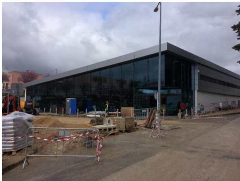
Figura 41 – Vista exterior da fachada envidraçada voltada à direção sudoeste.
