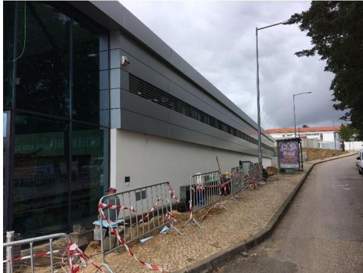
Figura 42 – Parede exterior do supermercado voltada para a direção sudeste.
