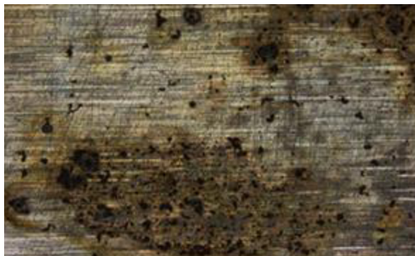
Figura 28 – Imagens de pontos de corrosão, amostra MB.
