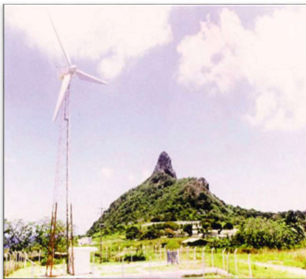
Figura 3 – Primeiro aerogerador de Fernando de Noronha
