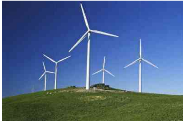
Figura 6 - Turbina eólica de eixo horizontal tipo hélice
