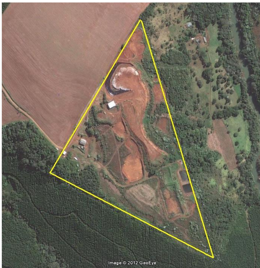
Figura 3. Delimitação do aterro sanitário de Francisco Beltrão – PR.
