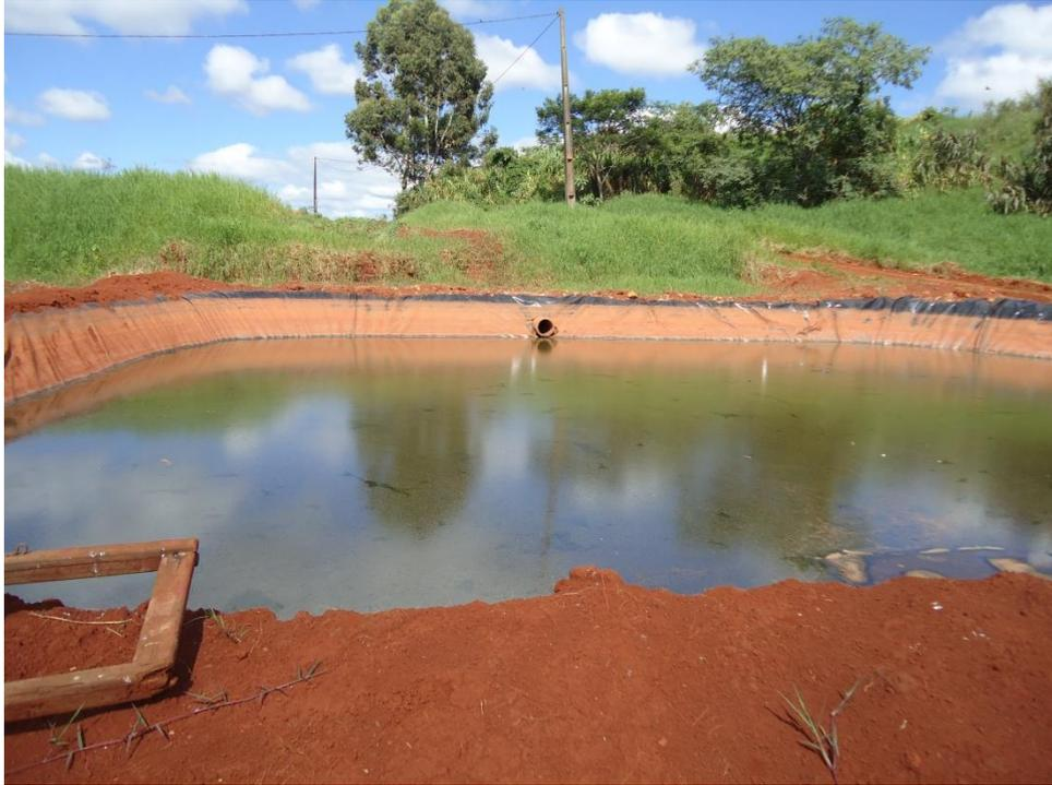
Figura 6: Lagoa anaeróbia das células abertas do aterro sanitário do município de Francisco Beltrão.
