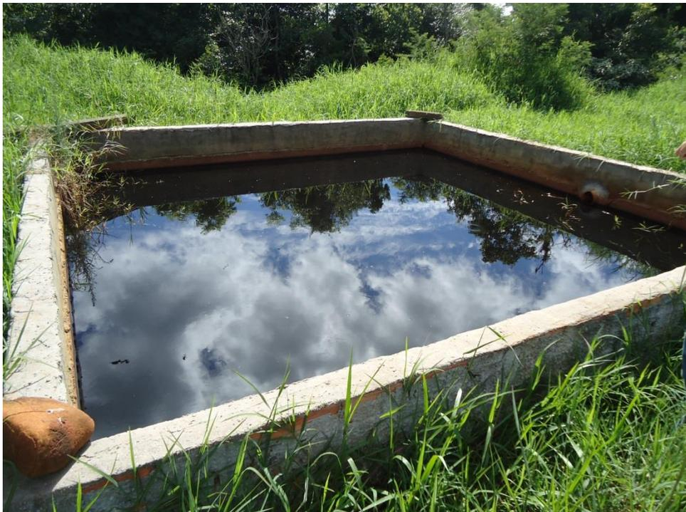
Figura 7: Lagoa anaeróbia das células fechadas do aterro sanitário do município de Francisco Beltrão.
