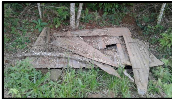
Figura 9 - Tampa inadequada e no nível do solo
