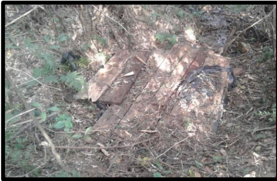
Figura 3 - SAI com tampa inadequada
