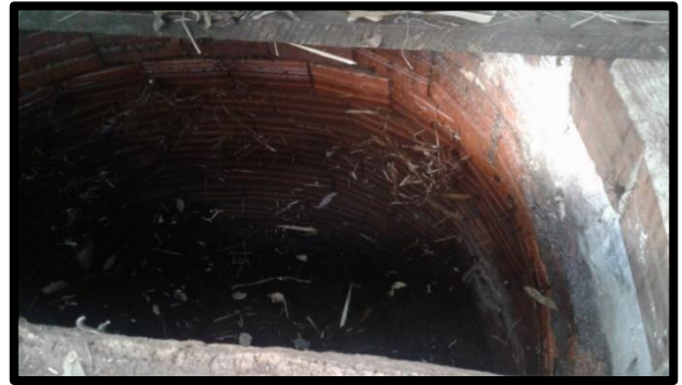
Figura 4 - Presença de folhas e resíduos vegetais na água da solução individual
