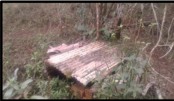
Figura 5 - Condições de proteção da SAI inadequadas e fonte exposta
