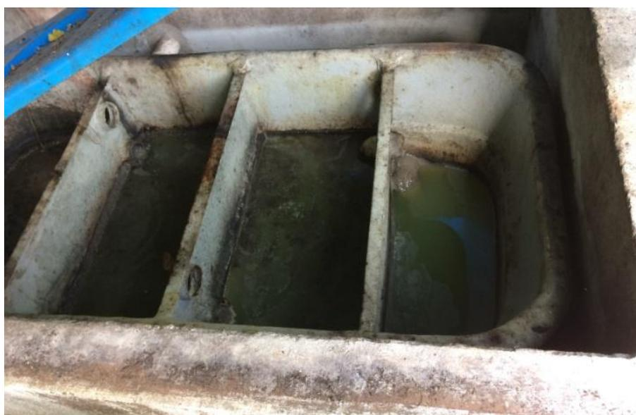
**Figura 13. Caixa separadora de água e óleo.**
