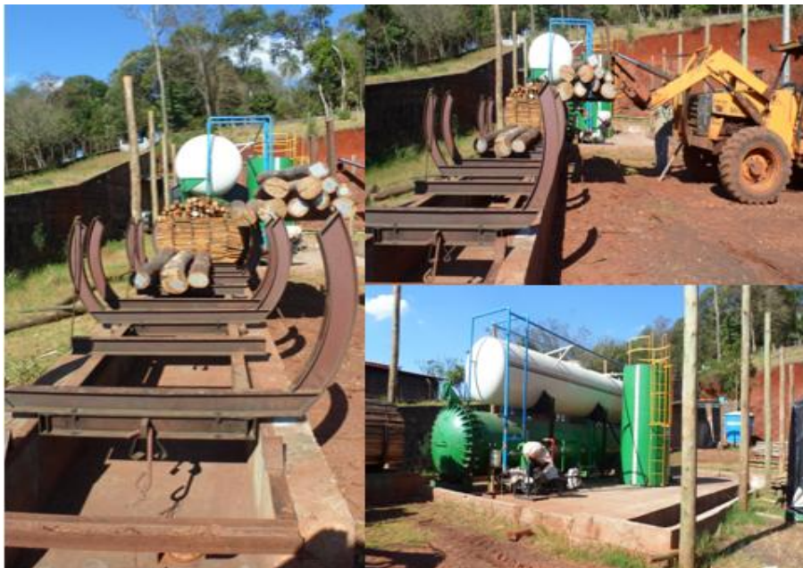
Figura 2. Estrutura necessária para tratamento de mourões pelo sistema a vácuo. Fonte: A autora, 2013.
