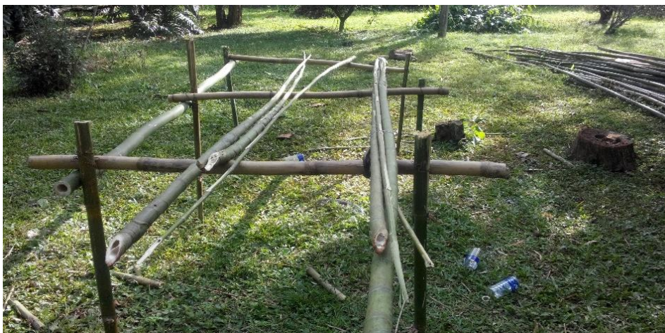
Figura 6: Montagem das estruturas Fonte: O Autor, 2015.
