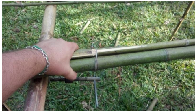
Figura 7: Amarração dos bambus Fonte: o Autor, 2015.
