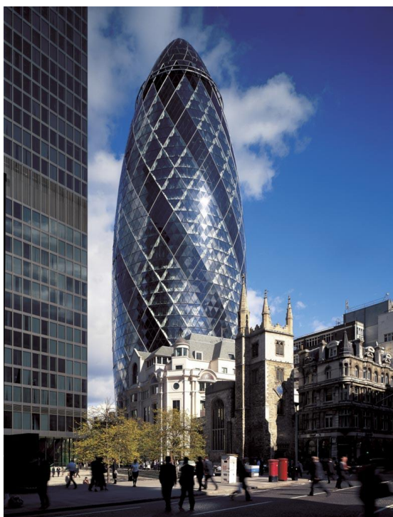
Figura 32 - Edifício Swiss Re Fonte: Norman Foster and Partners website (2014)
