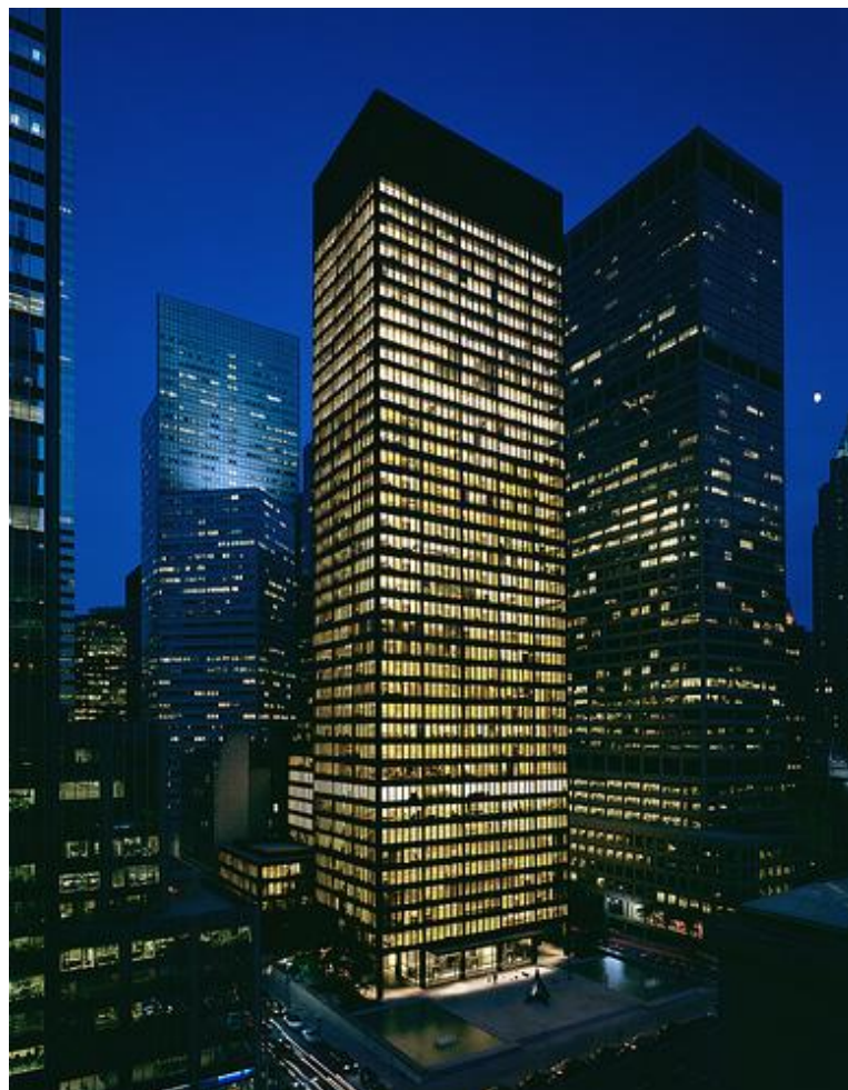
Figura 25 - Edifício Seagram em Nova York Fonte: Holanda (2013)
