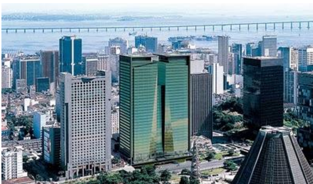
Figura 37 - Imagem aérea do edifício no seu contexto urbano Fonte: Skycrapercity website (2009)
