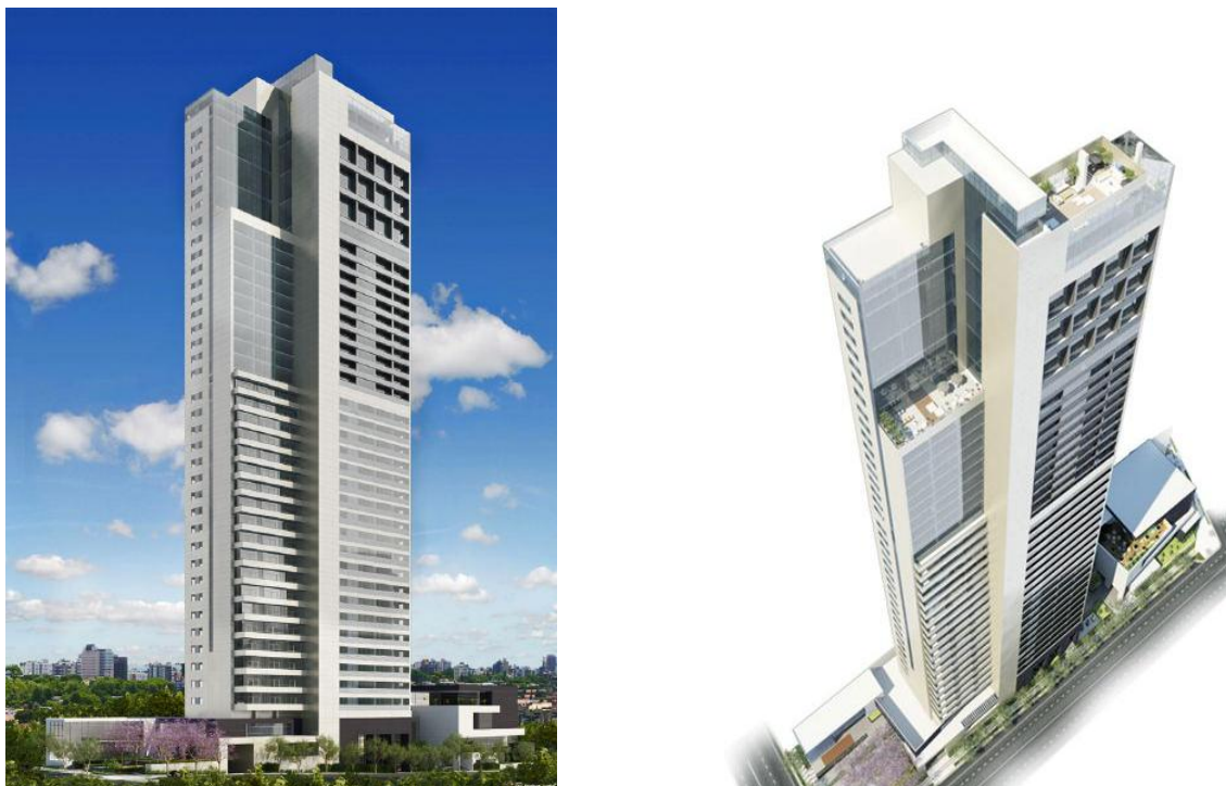
Figura 38 - Perspectiva do edifício Fonte: Konigsberger Vannucchi website (2009)
