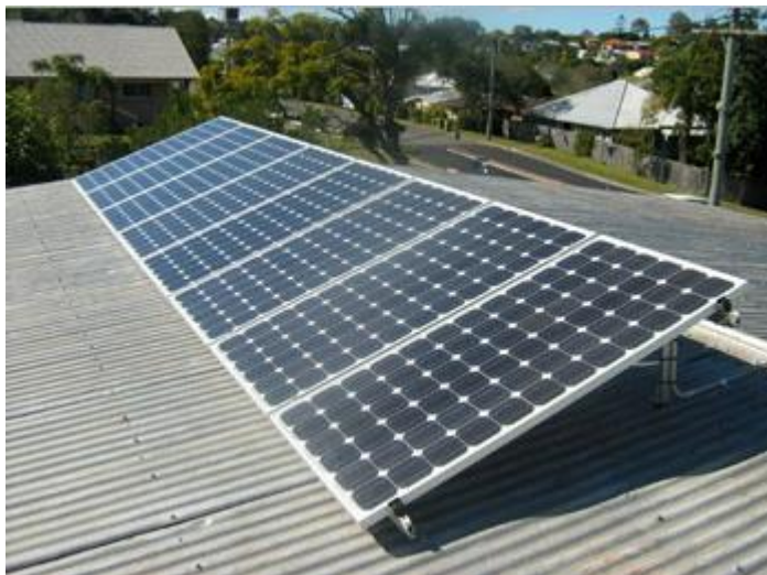
Figura 9. Montagem Rack
