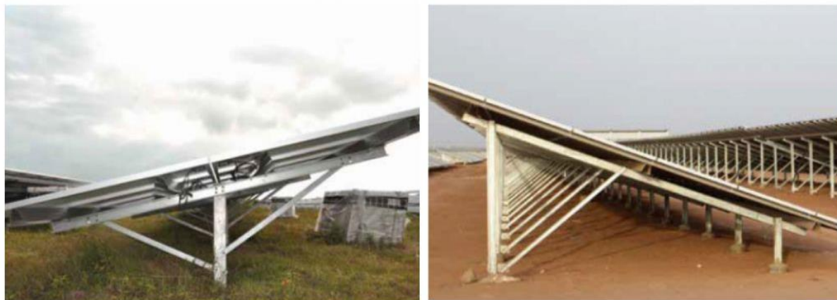
Figura 15. Rack com Um e Dois Pontos de Fixação (NUEVOSOL, 2017)
