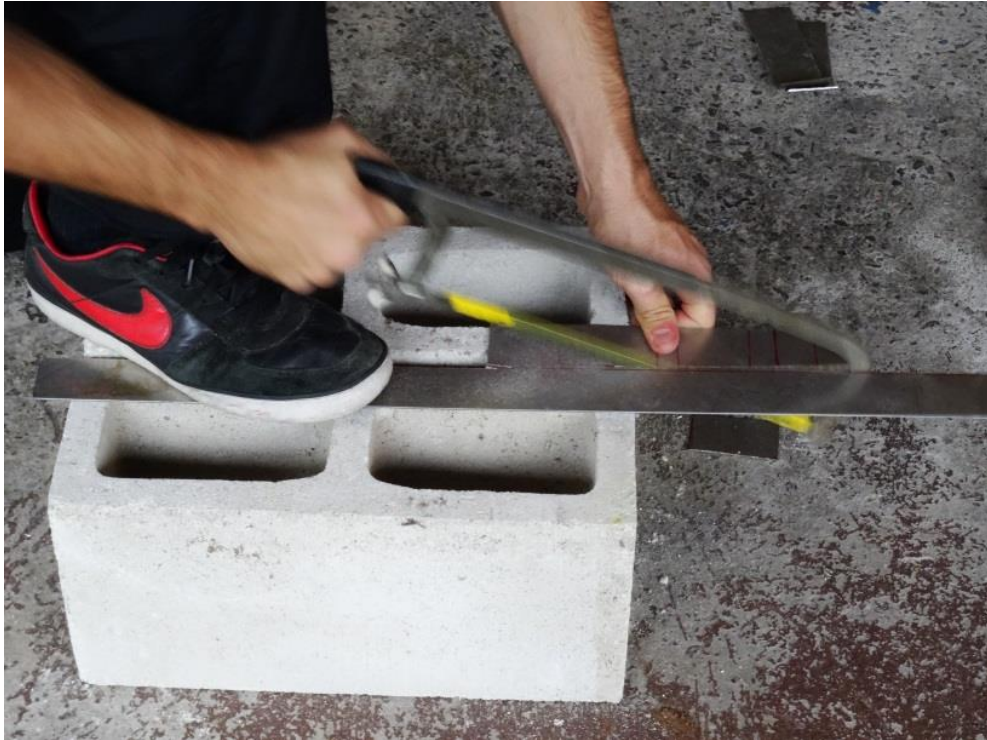
Figura 82 – Corte das chapas de apoio
