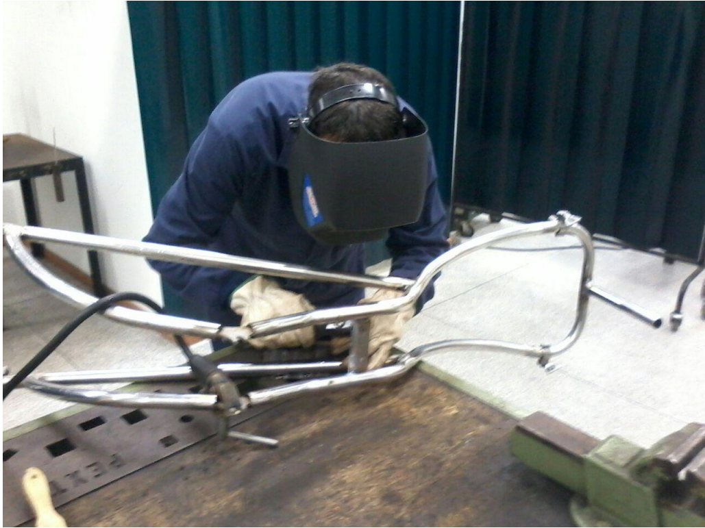
Figura 80 – Soldagem da cantoneira na estrutura
