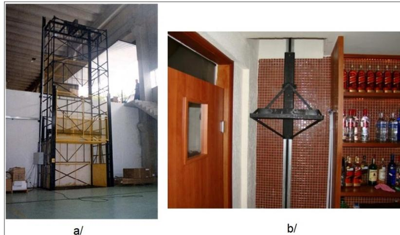
Figura 4. Elevadores de monta-carga industrial (a) e residencial (b). Adaptado de Netmultibusca (2013) e Olx (2013).
