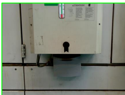
Figura 41 - Tubulação para coleta de água
