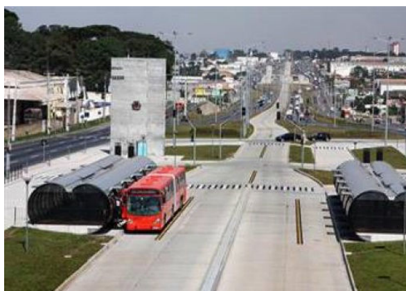
Figura 8 – Trecho 1 da Linha Verde finalizado
