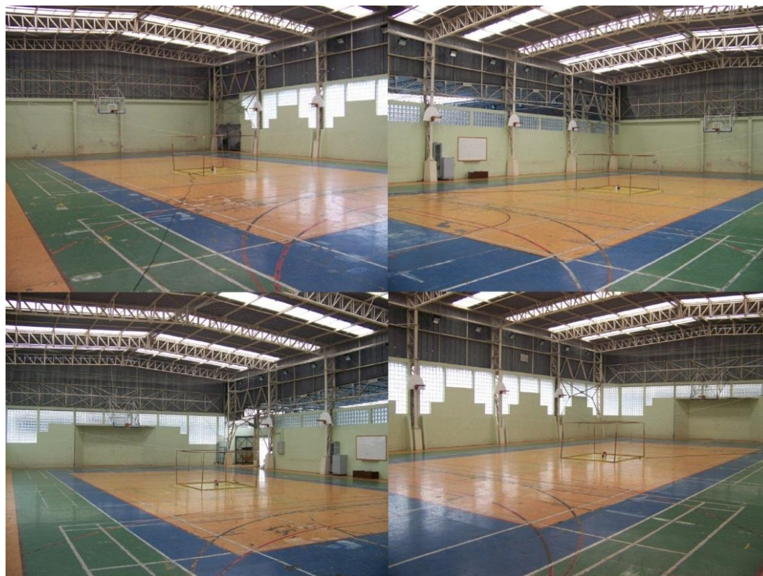
Figura 64 – Estrutura aramada do ginásio
