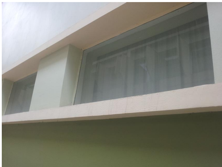
Figura 51 – Detalhe das janelas duplas da sala
