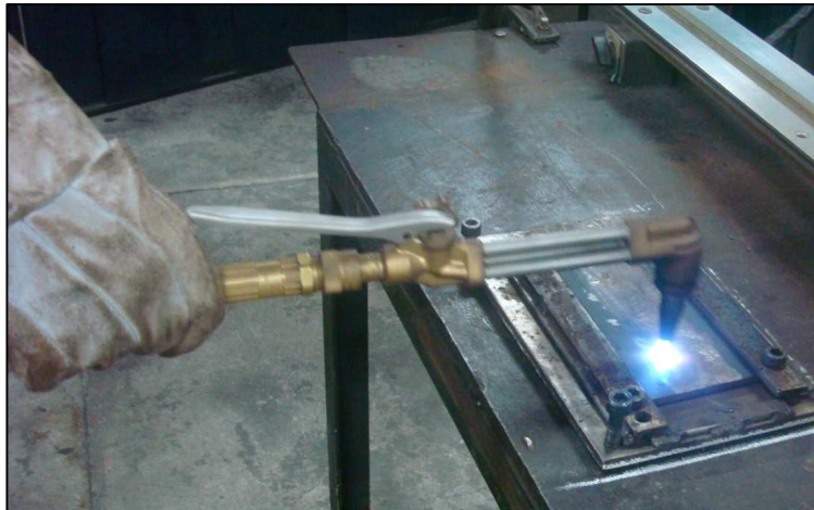
Figura 20 - Aplicação do pré-aquecimento com tocha
