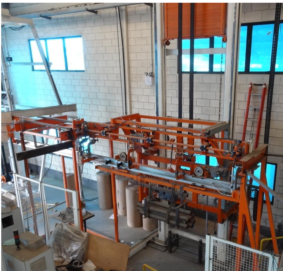
Figura 32 – Estrutura do Elevador de Carga
