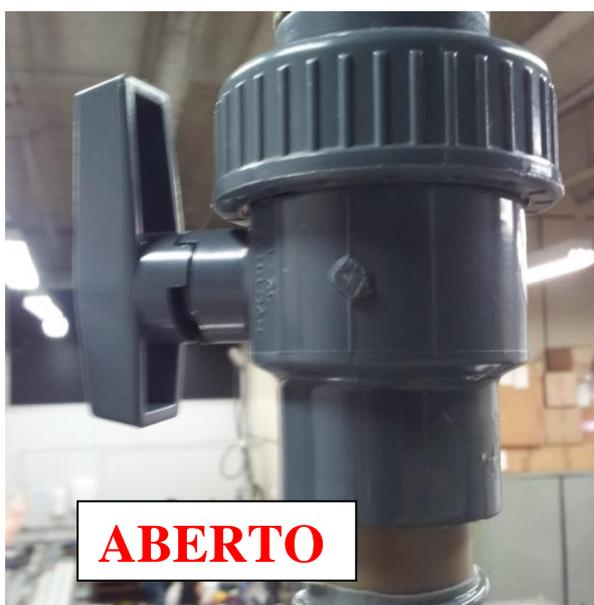
8. Abrir a válvula da caixa d'água;
