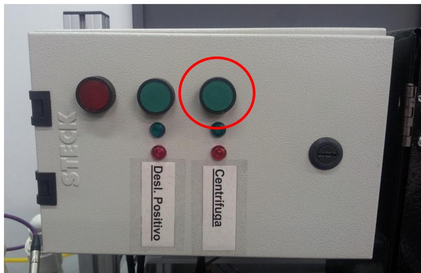
19. Alterar o inversor de frequência para o modo remoto (REM);
