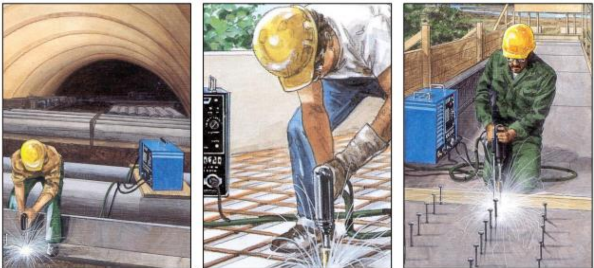
Figura 23 – Soldagem de pinos.
