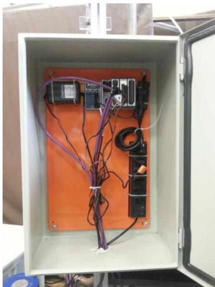
Figura 4.15. Quadro de comando e placa de aquisição de dados.
