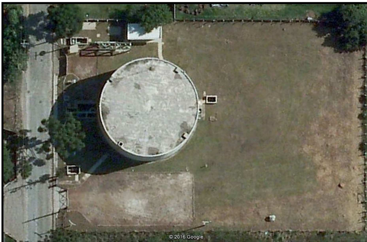
Figura 36: Foto aérea do reservatório apoiado São José Aeroporto. Fonte: Google Earth, 2016.
