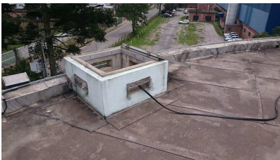
Figura 69: Foto da tampa de inspeção do reservatório. Fonte: Os autores, 2016.
