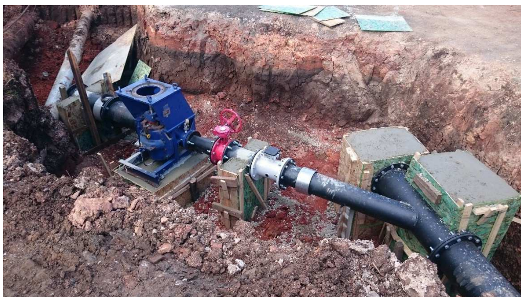
Figura 65: Foto dos blocos de ancoragem. Fonte: Os autores, 2016.
