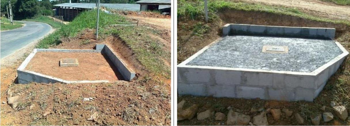
**Figura 42 – Implantação do piso isolante no Ponto de Teste**
