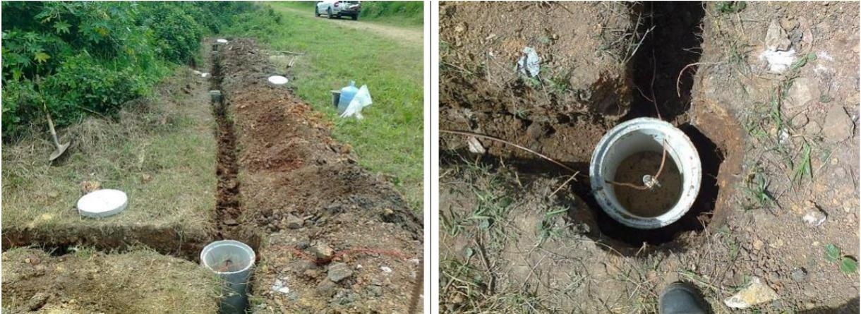
**Figura 44 – Implantação da malha de aterramento na CMI**
