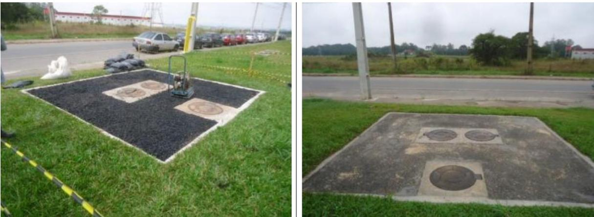
**Figura 43 – Implantação do piso isolante nas válvulas de bloqueio**
