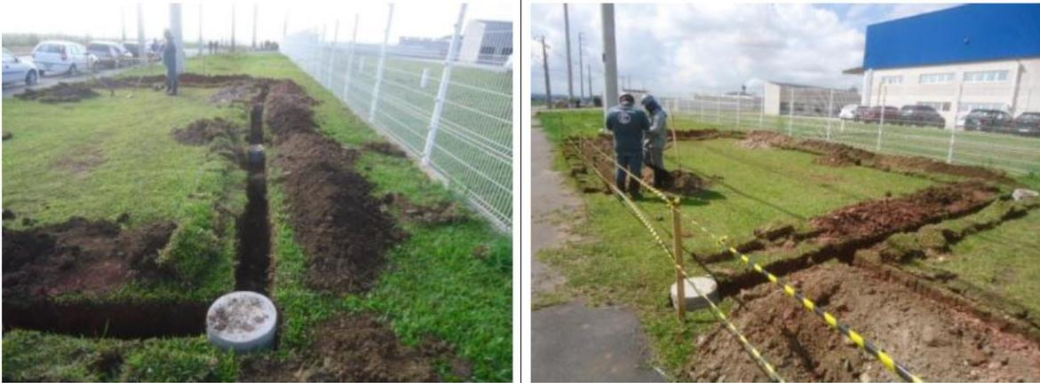
**Figura 40 – Implantação da malha de aterramento na ERP da Sumitomo**
