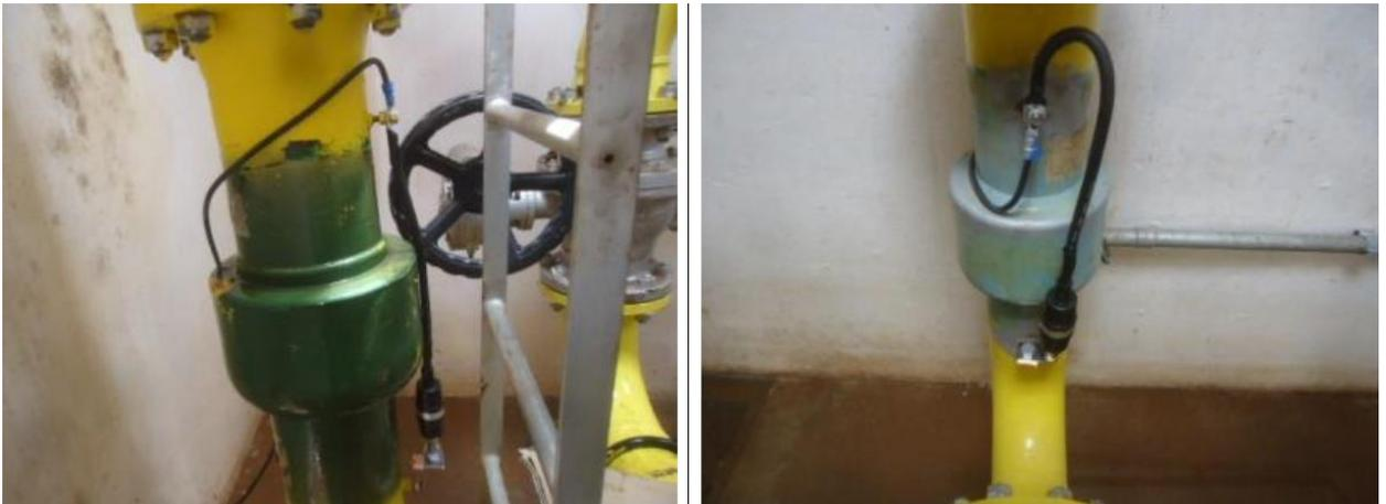
**Figura 41 – Instalação do supressor de surtos a jusante e montante da ERP**
