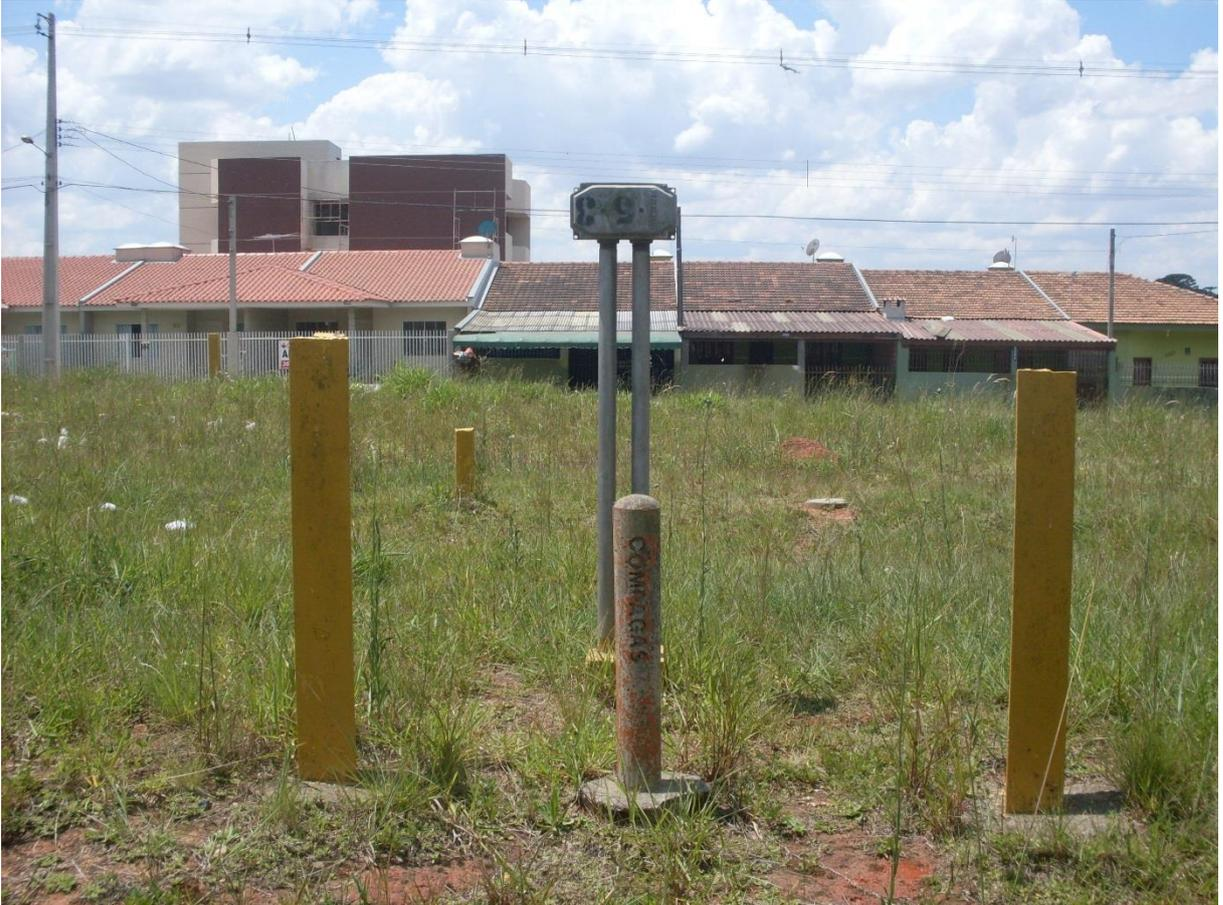
**Figura 30 - Detalhes do Ponto de Teste (PT)**
