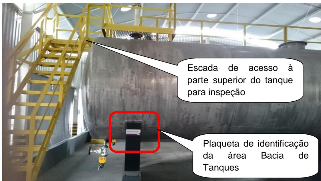
**Figura 31 – Identificação de localização da área Bacia de Tanques.**
