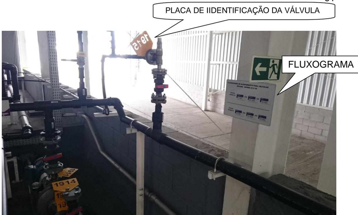
**Figura 24 – Localização dos fluxogramas de alinhamento de válvulas de envase – Bombas 03 e 04.**
